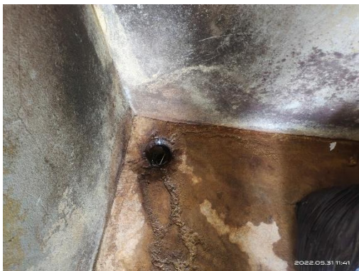
รูปที่ 22 ห้องพักขยะ / รางระบายน้ำเสียจากห้องพักขยะมูลฝอย
